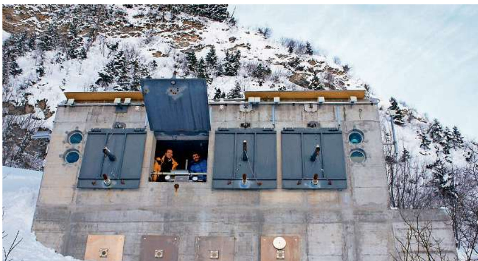
Mit einem Radar untersuchen Forscher vom Beobachtungsbunker aus das Fliessverhalten von Lawinen. Die Radarantennen befinden sich rechts neben der geöffneten Fensterklappe. Foto: Yann Gross
