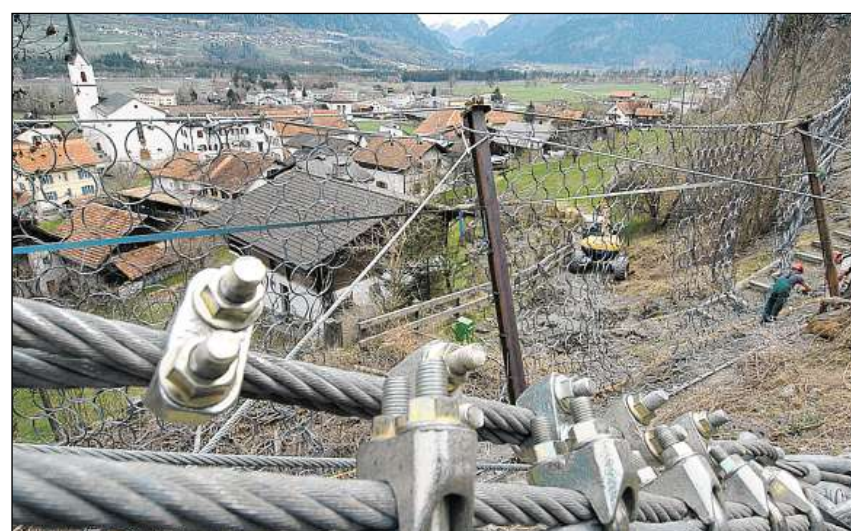
Per puder proteger l'infrastructura da crappa ston ins saver co quella rocla: Crappa rouda seglia lunsch, crappa cun cantuns seglia ad ault.
