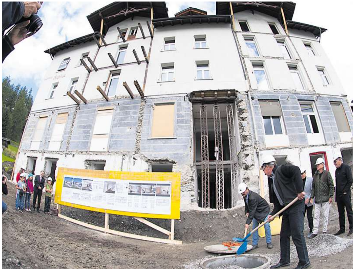
Die «Zeitkapsel» wird vergraben: Der Grundstein für das «The Alpina Mountain Resort & Spa» wird von den beteiligten Personen gelegt. (FOTO MARCO HARTMANN)
